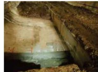
U型土留めによる片側施工
