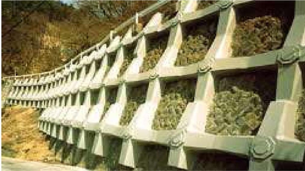
PCフレームアンカー工法
