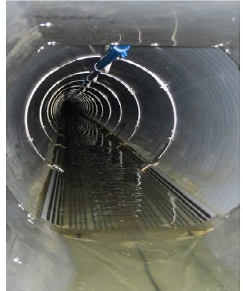
図-2 下水熱利用システム
