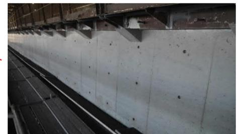
図-10 断面補修施工完了
