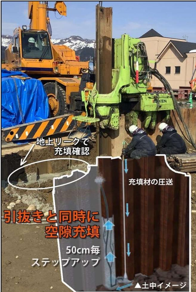
図-1 充填概要図
