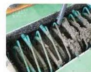
〔写真〕打設状況：間詰め部にコンクリートを打設します。
