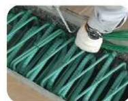
〔写真〕結束状況：スパイラル筋とループ筋を結束固定します。
