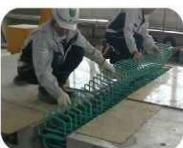
〔写真〕スパイラル筋挿入状況：上面からループ筋の間にスパイラル筋を挿入します。
