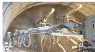
自動化に適した最適なノズルワークを設定し、複雑な凹凸を持つ岩盤面でも、仕上面に対して高い精度で、平滑にコンクリートを吹付けます。
