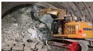
高速3Dスキャナによる切羽の点群データと設計断面から「アタリ」を容易に判別し、生産性と安全性を高めます。
