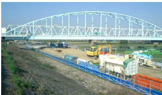
写真-4 橋梁下における施工
