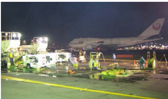
写真-2 空港誘導路における施工
