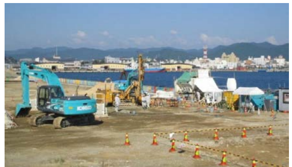
写真-3 護岸背面部の施工
