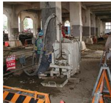
写真-5 空頭制限下の施工
