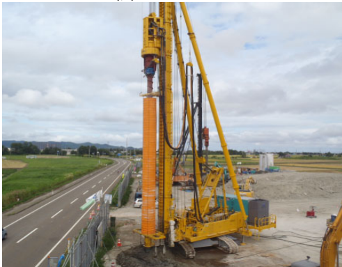
施工状況 (KS-S・MIX)
