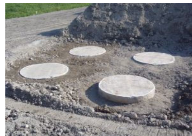
出来形杭径確認
