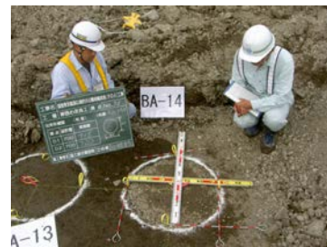
出来形杭径確認
