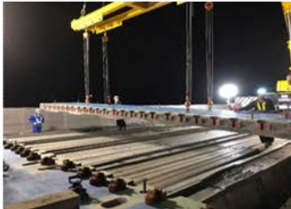
①床版設置
